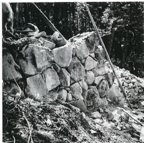
伝二の丸下帯曲輪 昭和35～40年の石垣修理状況(滋賀県提供)
