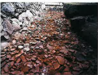
天主台直下の凄まじい火災の痕跡
